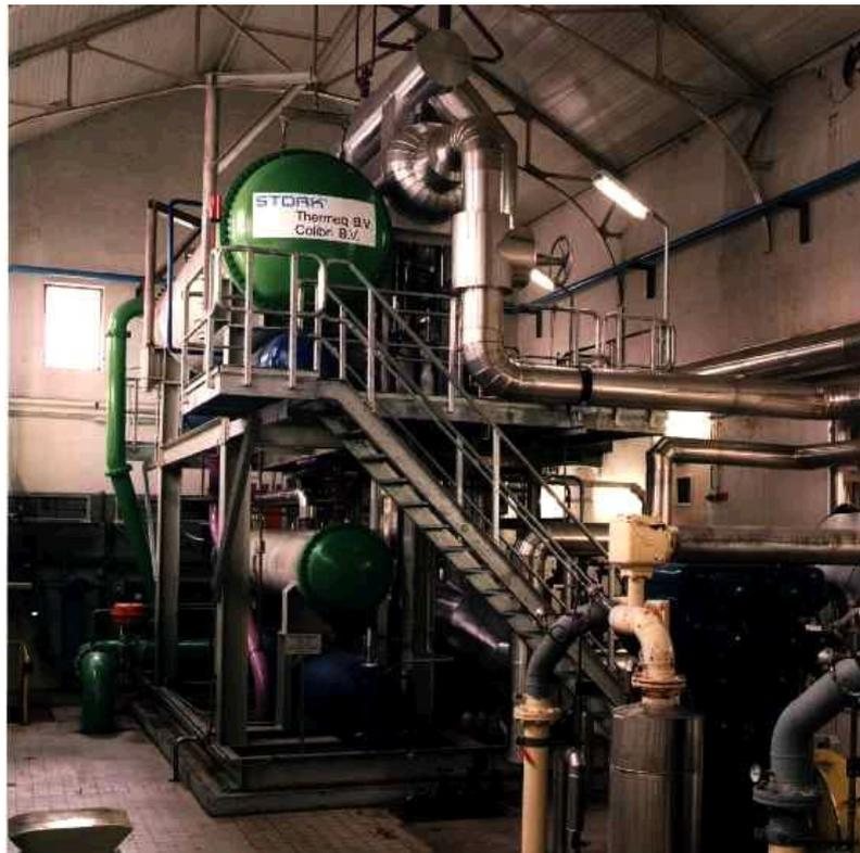
ARP-C-14 instalada en una fábrica de margarinas en Rotterdam, 1400 kW a  $-23^{\circ}\text{C}$ .
