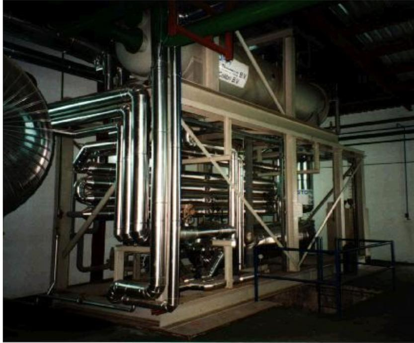
ARP-M-10 instalada en una fábrica de congelados de verduras en Talavera de la Reina, 700 kW a  $-30^{\circ}\text{C}$ .
