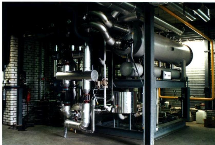
ARP-S-2 instalada en una empresa cárnica en Holanda, 250 kW a  $-10^{\circ}\text{C}$ .
