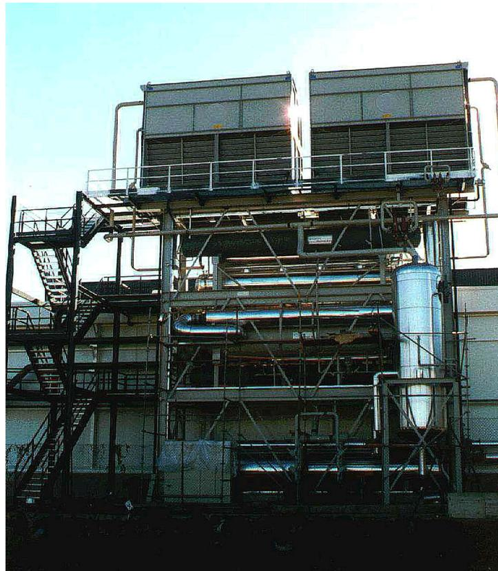
ARP-M-25 instalada en una empresa cárnica en Rioja, 2500 kW a  $-10^{\circ}\text{C}$ .
